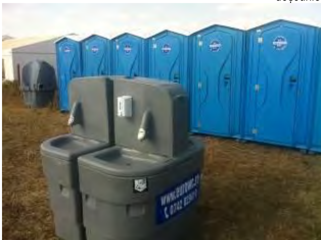
Model de soluție de asigurare a condițiilor de igienă pe amplasamente temporare cu un număr mare de lucrători: toalete ecologice, cu bazin etanș, vidanjabil, tratat chimic; lavoare de spălare cu rezervoare etanșe ce asigură apa de spălare ce este apoi re-introdusă în rezervor distinct, etanș, vidanjabil
