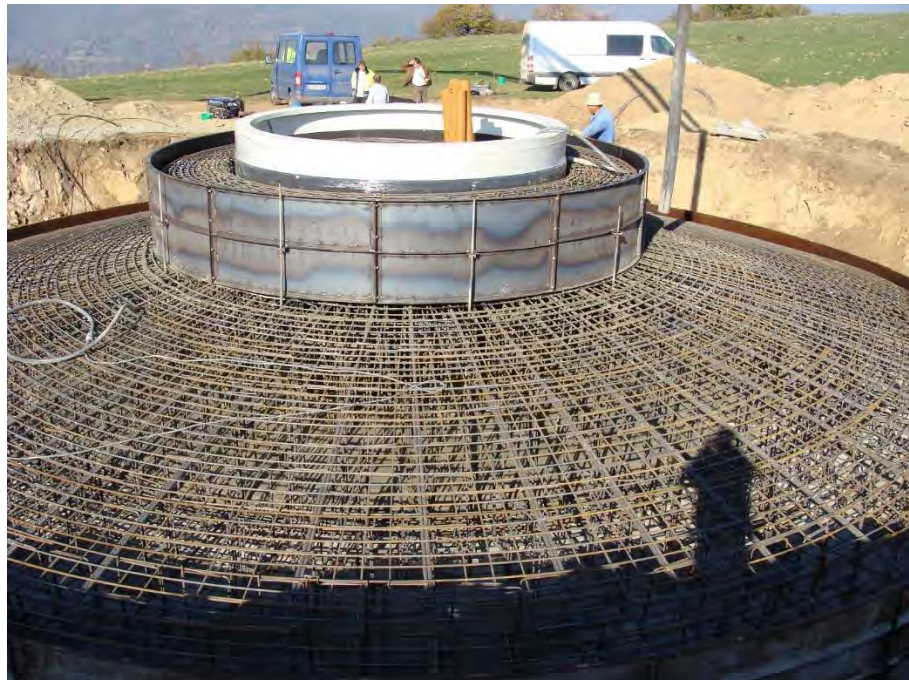
Figura 10. Aspectul armăturii fundației unei centrale eoliene
