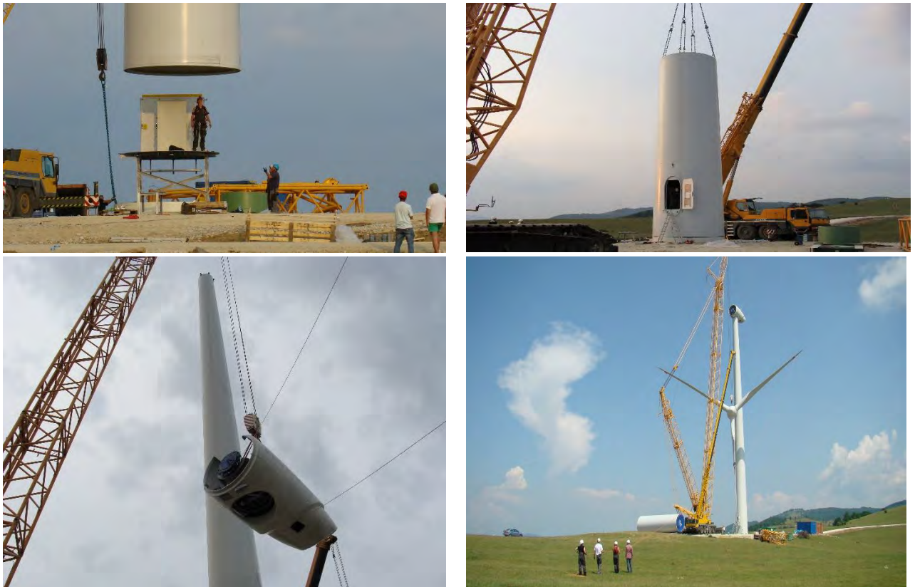
Figura 13. Faze de montaj ale unei centrale eoliene
