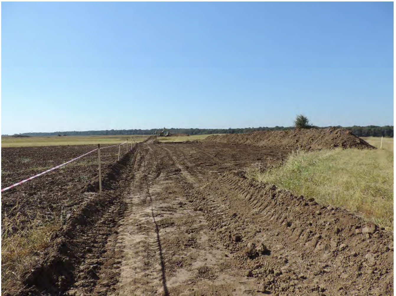
Figura 6. Aspect al acțiunilor de decopertare a solului vegetal
