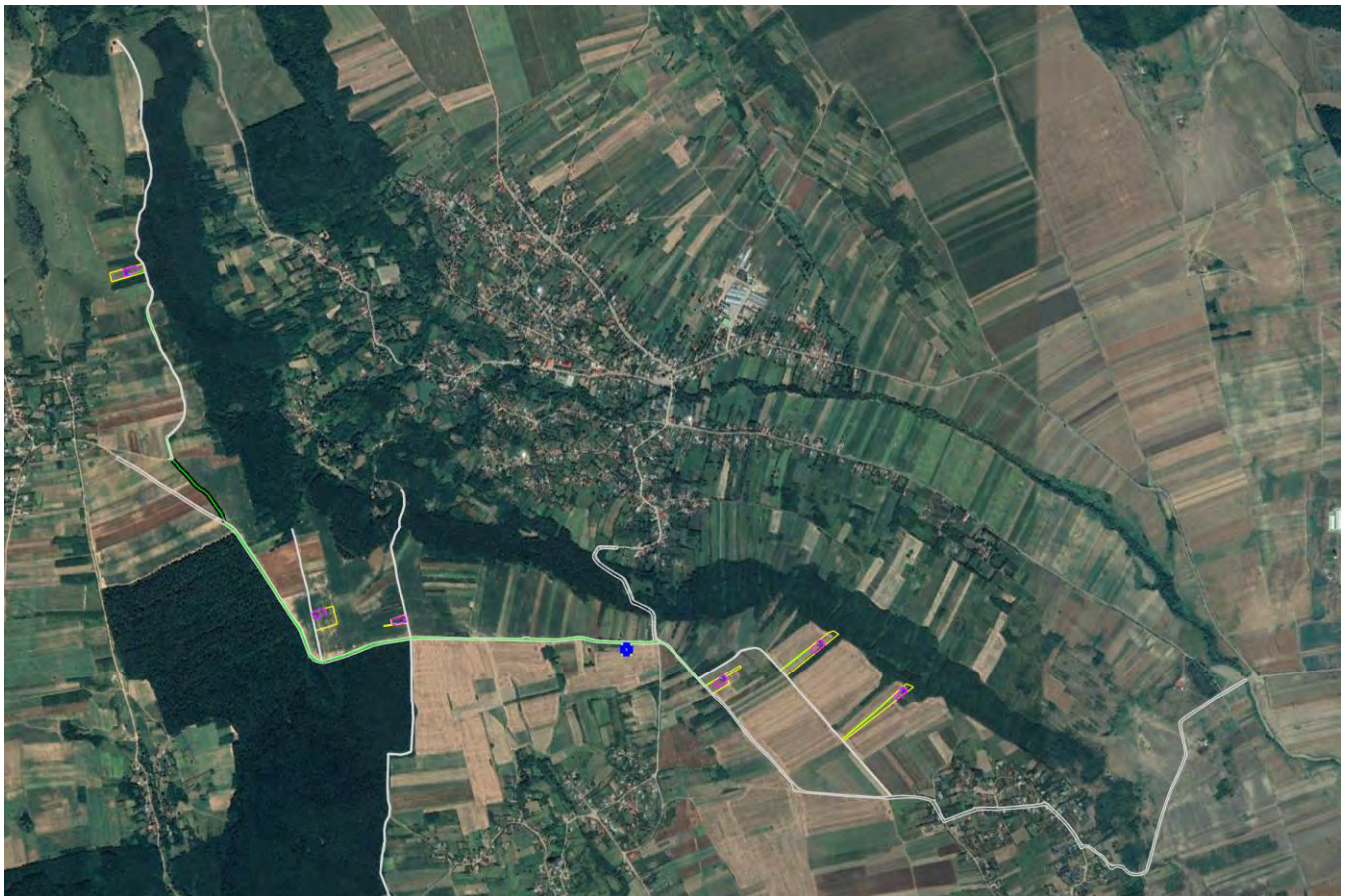
Figura 1. Elementele de ansamblu ale proiectului ( încadrare în zonă ): contur galben – parcele agricole afectate; contur roz – platformele de montaj; cerc albastru – perimetrul fundației centralelor
