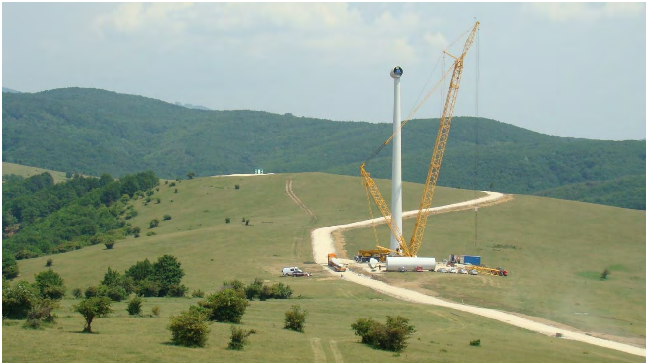
Figura 7. Aspectul de la nivelul unui front de lucru (platformă temporară de montaj)
