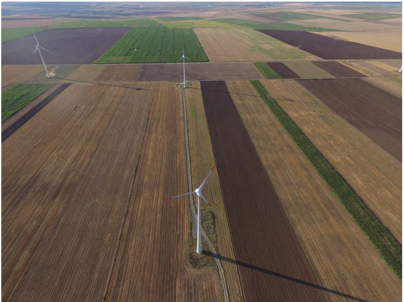
Figura 11. Parc eolian situat într-un amplasament cu funcțiune similară celui de la Costești Se observă modalitatea de redare în circuit agricol/natural a fostelor platforme de lucruși amprenta la sol (impact rezidual) limitat al centralelor
