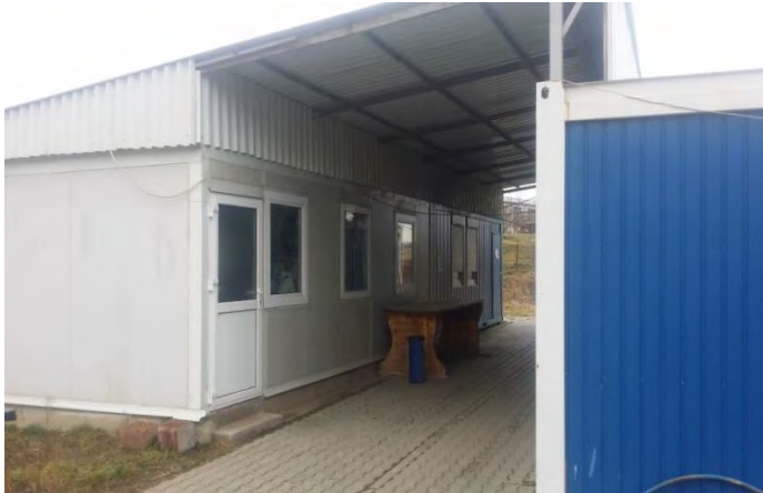
Soluție de amenajare containere modulare
