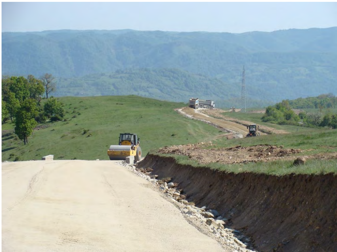
Figura 5. Aspect de la nivelul unor lucrări de amenajare a unui drum tehnologic pentru un parc eolian
