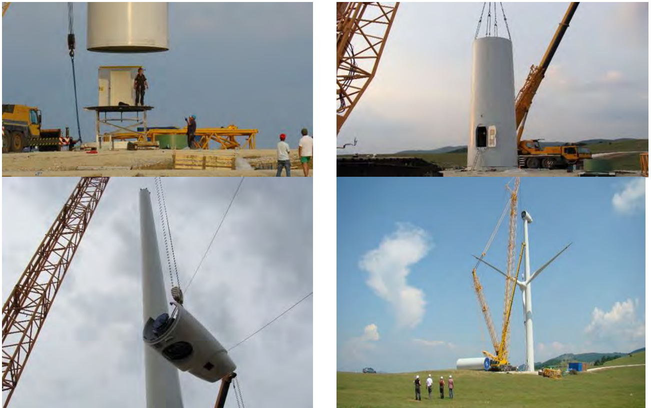
Figura 13. Faze de montaj ale unei centrale eoliene
