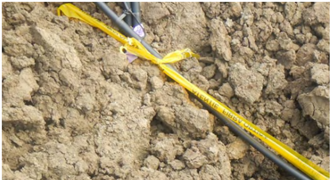
Figura 3. Model de pozare a unui cablu electric însoțit de panglica de avertizare
