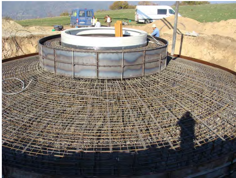
Figura 10. Aspectul armăturii fundației unei centrale eoliene
